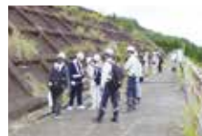
のり面点検実習の状況
