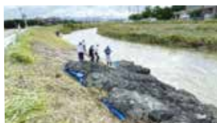
筑後川支川巨瀬川 右岸9K050
