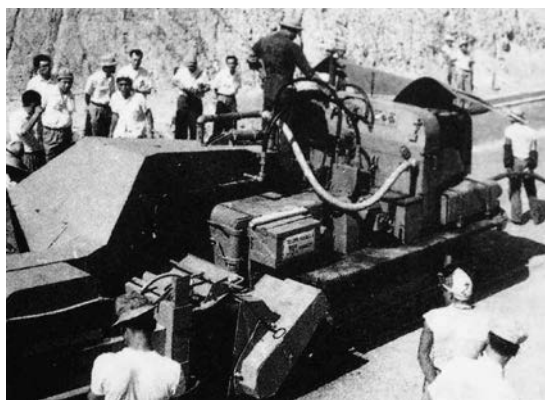
アスファルト舗装。そのスピード仕上げに驚かされた。
