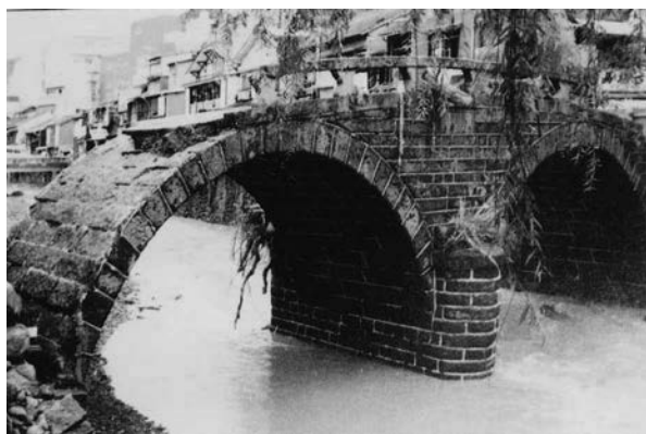
長崎大水害で破壊された眼鏡橋
