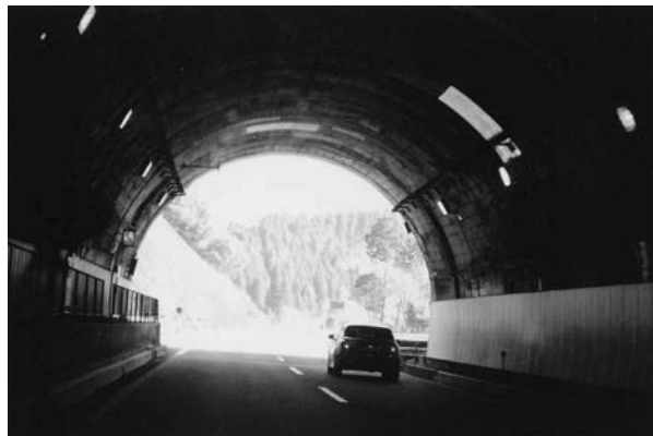
日南層群に苦闘した天神トンネルの内部
