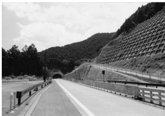
のり面崩壊が発生した三軒茶屋トンネル（中央坑口）付近
