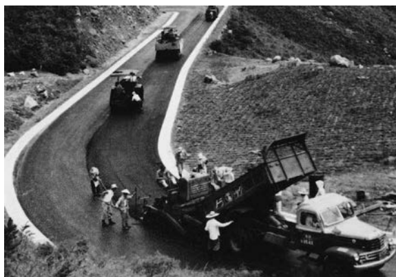
全面アスファルト舗装された雲仙島原道路
