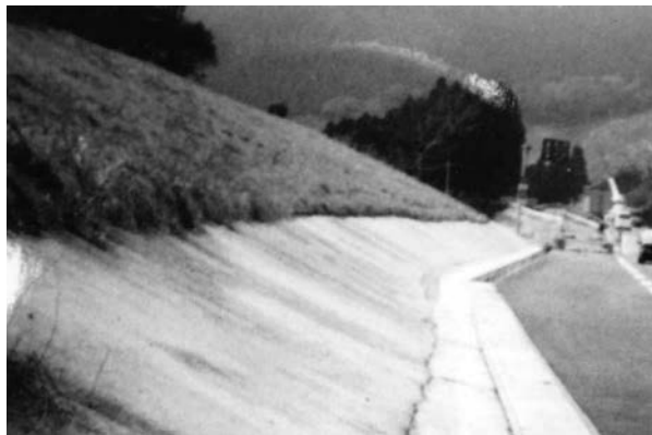
宮崎道では日南層群のため緩いノリ面で造られた
