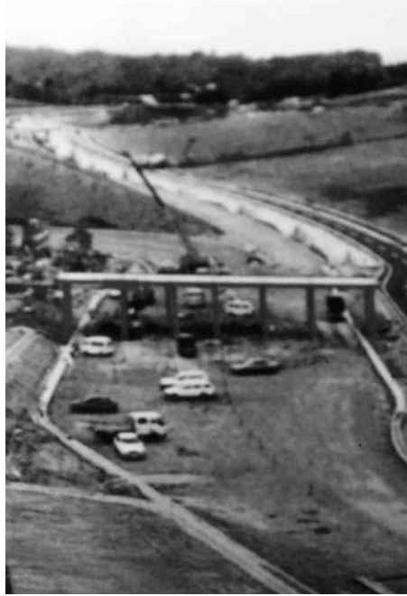
建設中の大分IC 大分IC付近を東向きから南向きに変更。早生は当時、法定予定路線に入っていなかった東九州道を考えてのことと説明。
