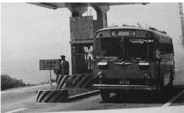
島原道路の料金所
