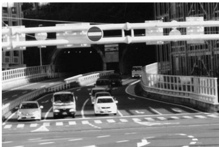
オランダ坂トンネルの出島側出口。 住宅の下を掘削、市民病院への配慮など 都市土木のむずかしさが山積した工事だった。
