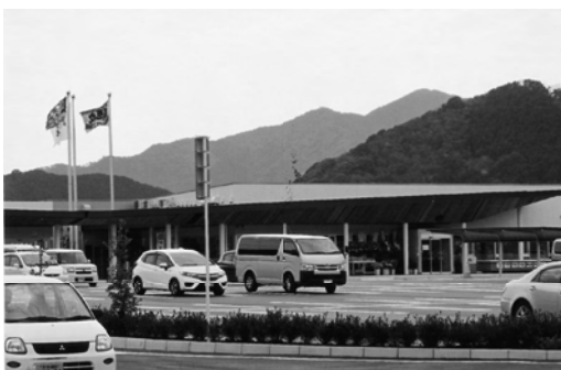
全国初の防災コンテナハウスを備えた川南PA
