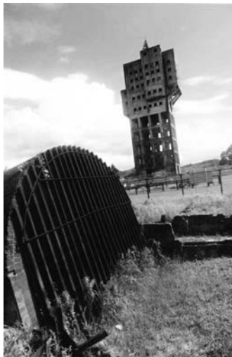
志免鉱の槽と坑口
