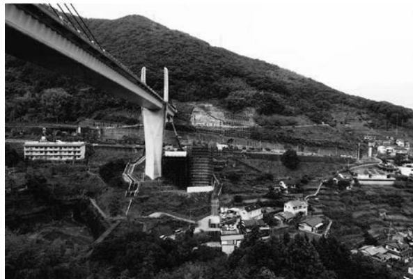
大きな谷を渡る日見夢大橋。その横で四車線用の架橋工が進んだ。
