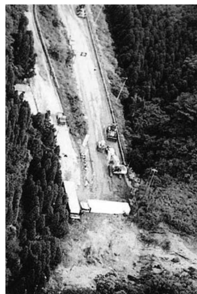
土砂に流された大型トラックが道路を完全に塞ぐ（鹿児島県福山町で）
