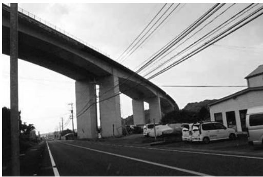
国道34号またぐ鈴田橋
