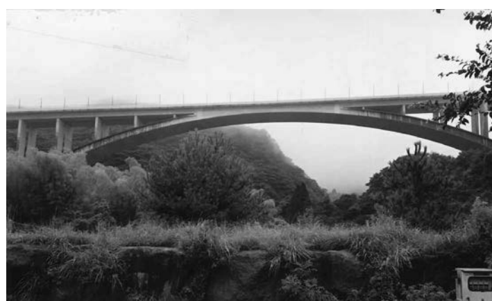
明礬大橋（東九州道と大分道が重なる別府～大分間） 明ばん温泉郷の上に架けられた、美しさと強さを持つ コンクリート・アーチ橋。
