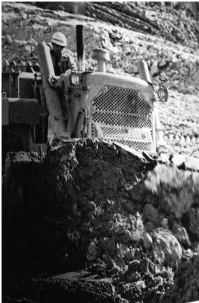
九州道建設に大型重機が導入され、これまでの道路工事を一変させた。
