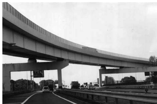
鳥栖JCTに新たに架設された「サガンクロス」
