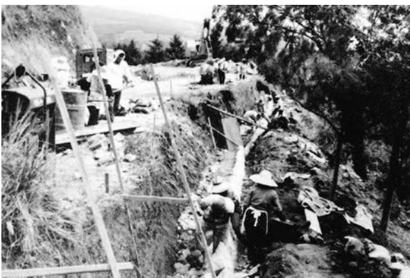
初めてのコンクリート壁の導入
