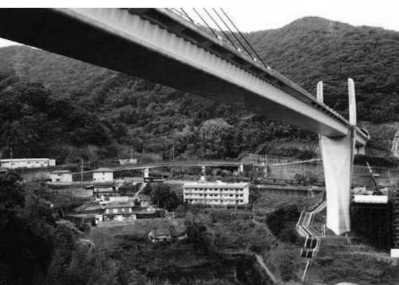
大きな谷と国道34号、バイパスをまたぐ夢大橋
