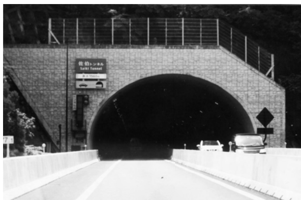
最後のトンネル工事になった佐伯トンネル
