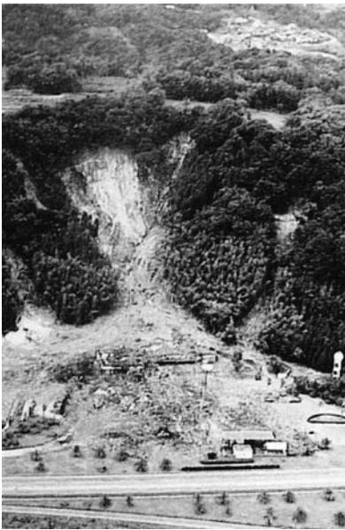
シラスの脅威―九州道・桜島SAを飲み込んだ土石流
