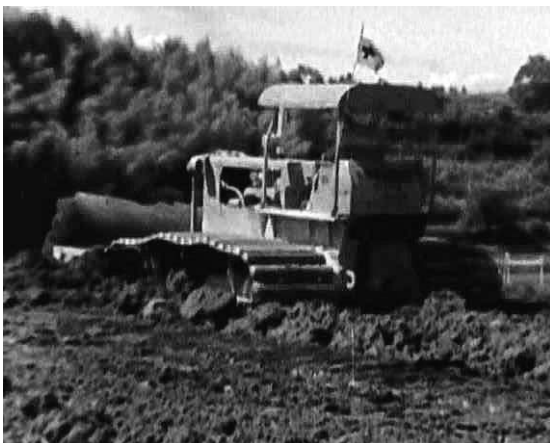
灰土の中で動けなくなったブルドーザーも
