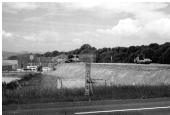
南九州道工事現場。ミッシングサークルの解消に向けて工事は進む。
