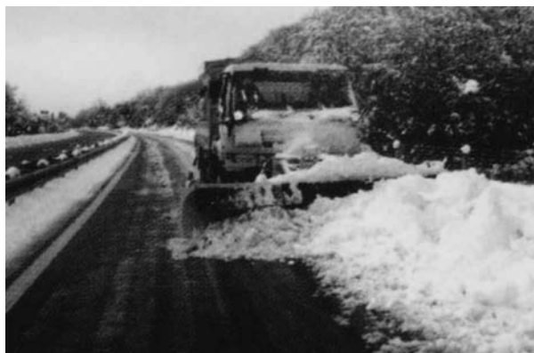
大分道の除雪作業
