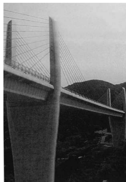
曲線を描く日見夢大橋の主塔
