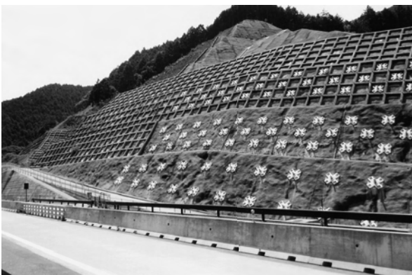
大規模な「滑り」で補強されたのり面＝三軒屋地区
