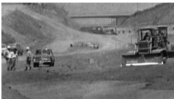
灰土克服で進む九州道
