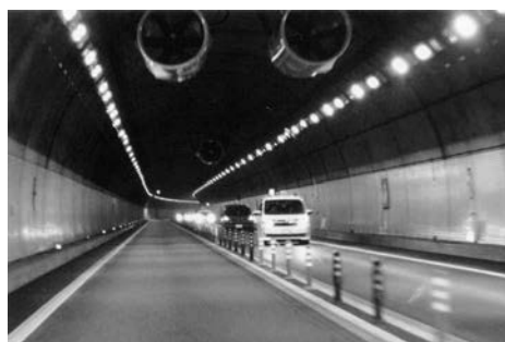
九六位トンネルを快適に走る（東九州道）
