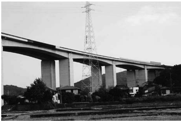
住宅などの上部の工事はむずかしい
