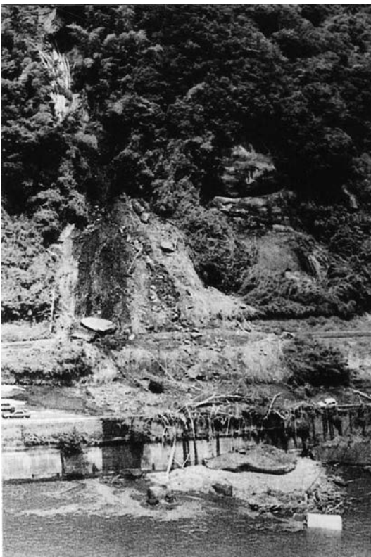
国道10号とJR日豊線を破壊した土砂くずれ。 （鹿児島市吉野）
