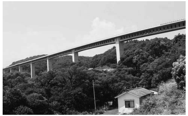
田久保川橋（PC10径間）世界で初めての構造形式、張り出し架橋。
