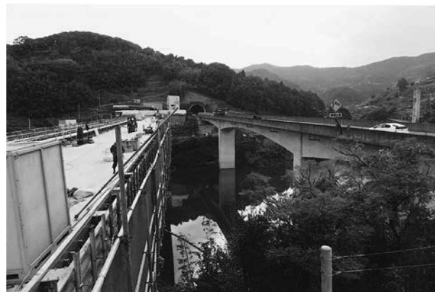
中尾橋―あらかじめ造られた橋脚を使って架橋されている
