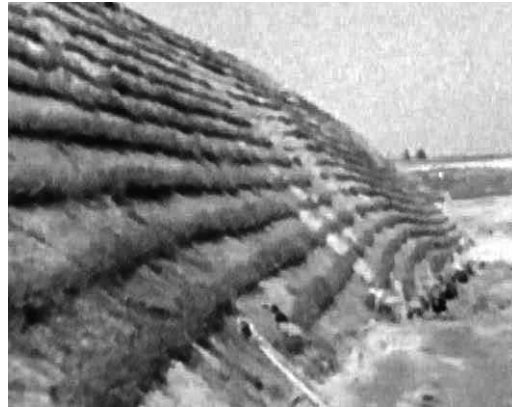
のり面の植栽には黒ボクが使われた
