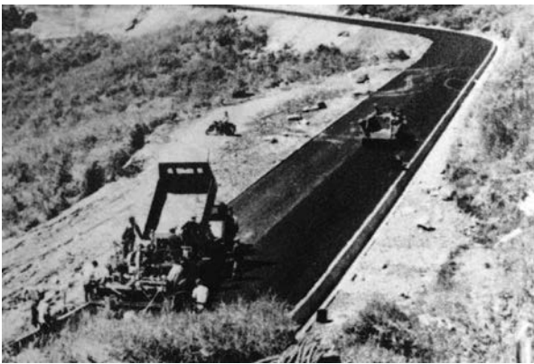
島原道路—アスファルト舗装のはじまり
