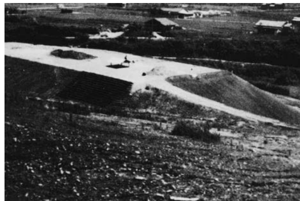
九州道建設で行われた試験盛土はボタ、灰土、シラスなど特殊土壌克服に大きな役割を果たした。
