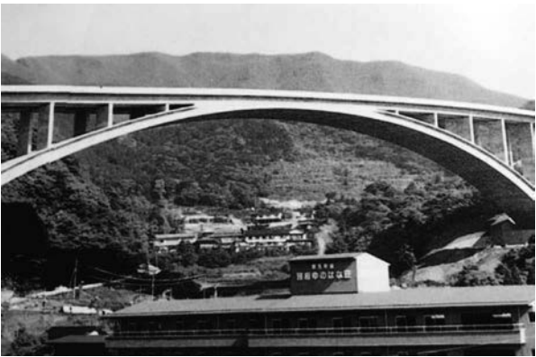
③完成した明ばん大橋
