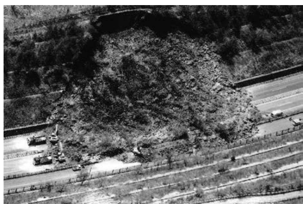
大分道 熊本地震でのり面崩壊
