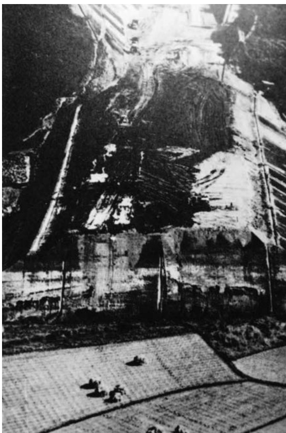
大規模な試験盛土が造られた（熊本・植木付近）
