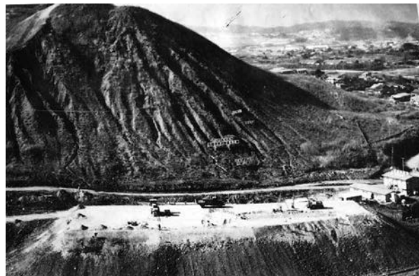
ボタ山の横に造られた試験盛り土
