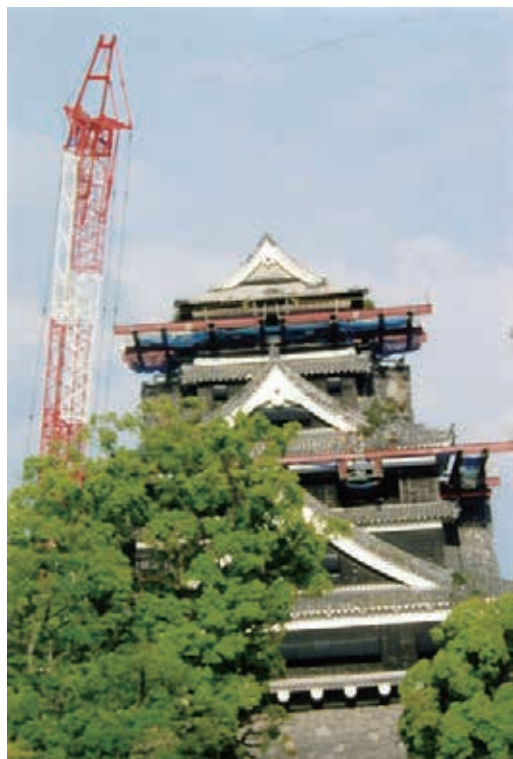
修理中の天守閣
