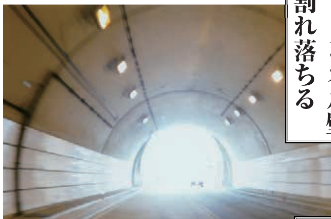
復旧した俵山トンネル
