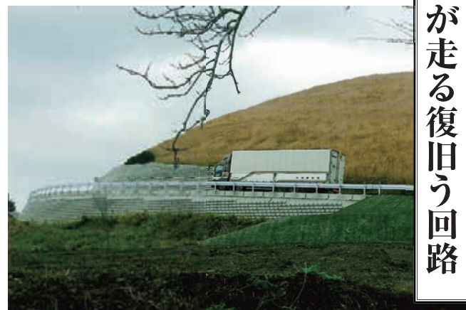
復旧した県道28号のう回路。大型トラックが走れる。
