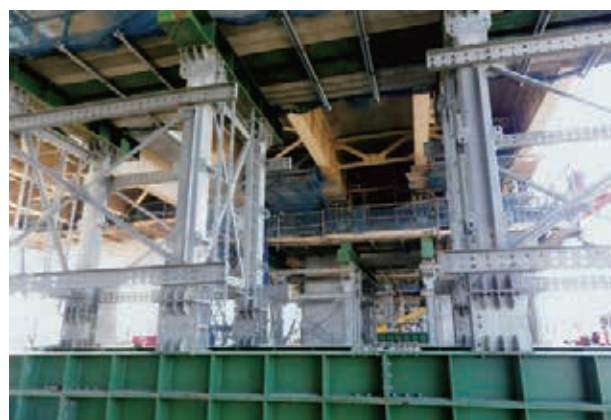
落橋防止のための仮受け台（九州道・木山川橋）
