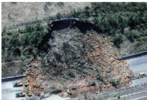
崩壊して大分道を埋めた土砂
