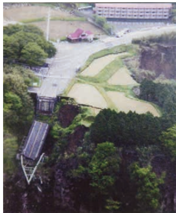
折れた阿蘇大橋 橋桁が急崖にぶらさがっている（国道325号）
