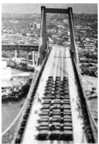
36台のトラックで橋の「たわみ」の実証試験
