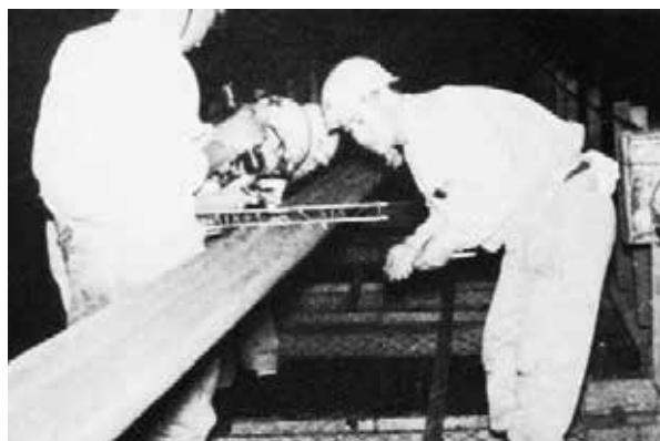
温度差による「たるみ」を整える調整作業。
