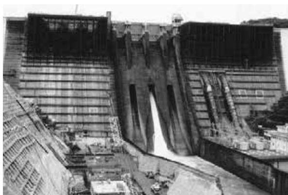
堤体の左側下段に放流用の穴を開ける
