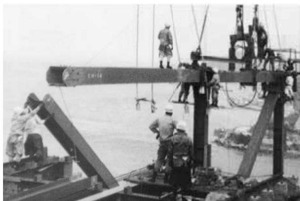
風に強い橋を造るために、補剛トラス桁が組み立てられてゆく
