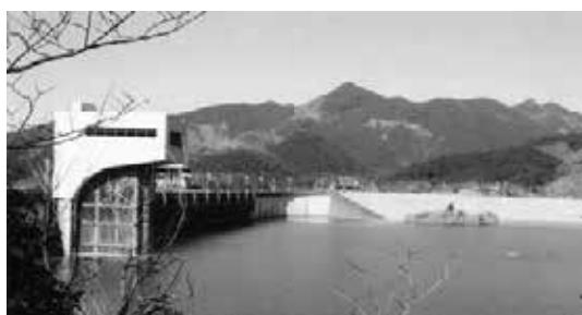
重力式コンクリート（右）とロックフィルの複合型ダム（左）となった竜門ダム
