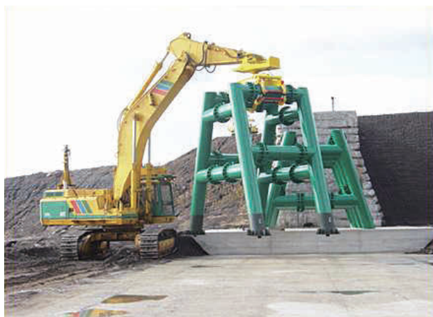
「スリット」の据え付けを無人化施工で行う。高度の技術が必要となる
