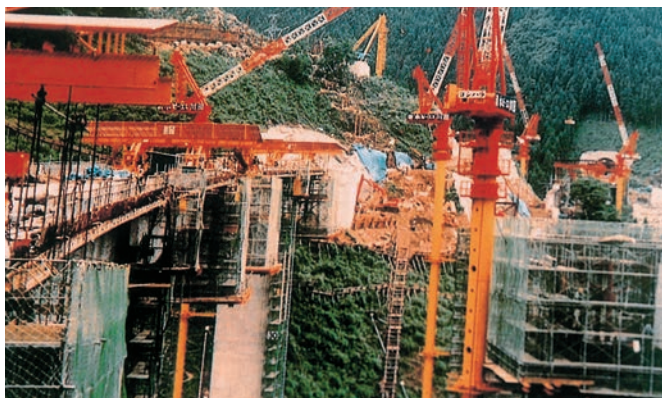
登保第1橋 タワークレーン／インクライン／ケーブルクレーンなどでの施工
