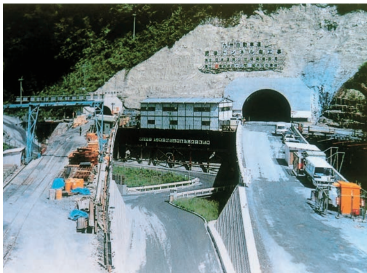
肥後トンネル南口工事
