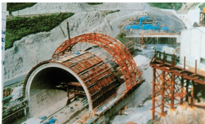
肥後トンネル人吉側坑口
