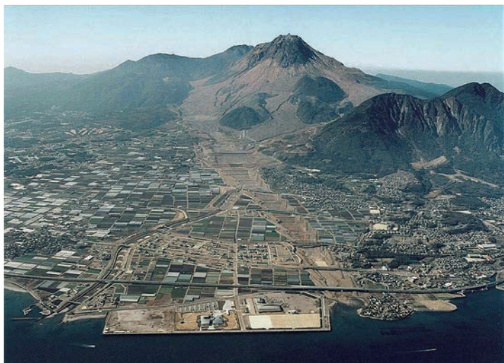
水無川下流から、導流堤、砂防えん堤、床固めなど防災施設が完成している
