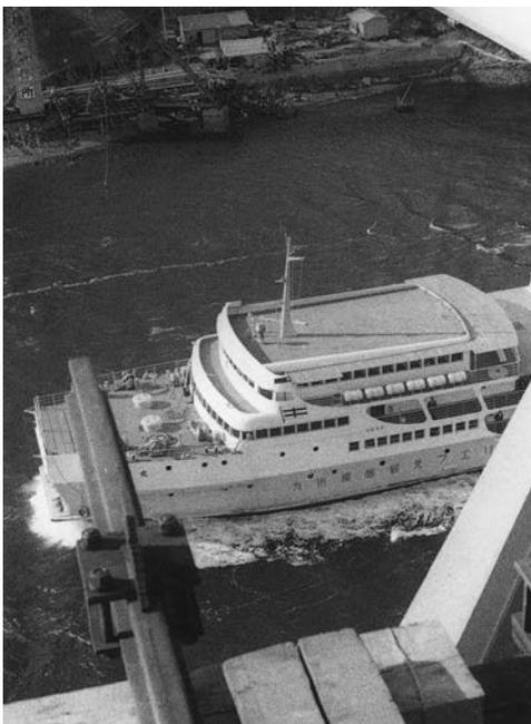
航行に支障がないよう橋脚を陸上に、橋の高さも配慮した（工事中に撮影）
