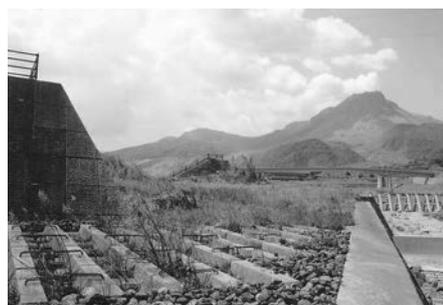
導流堤が土石流の流れをコントロールする
