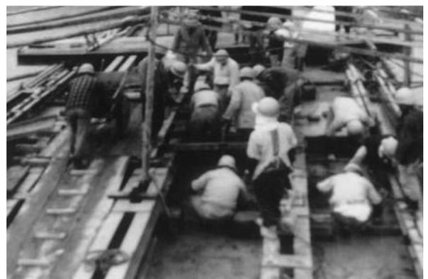
連結部でのコンクリート打設
