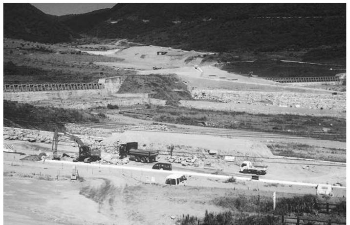
水無川2号砂防えん堤。無人化施工の新技术が駆使されている
