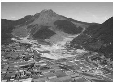
上流から水無川2号えん堤、同1号えん堤が完成。土石流の流れを止め、下流の安全を守っている
