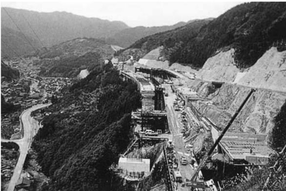
坊ノ木第1、2橋 仮栈橋を利用してトラッククレーンでの橋架工事
