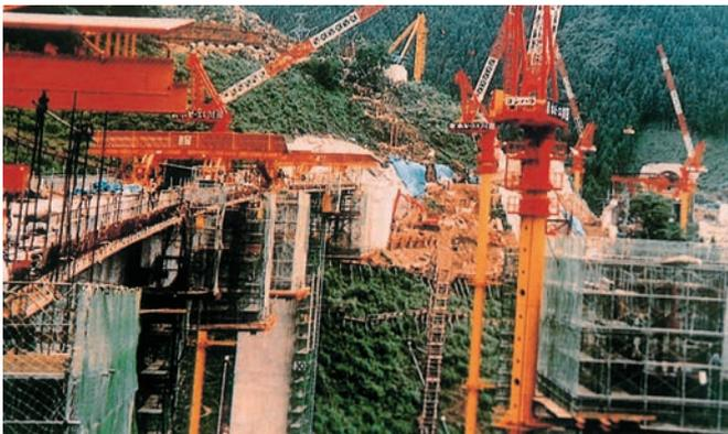
登俣第1橋 タワークレーン/インクライン/ケーブルクレーンなどでの施工
