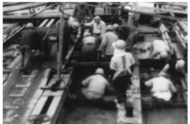
床版のためのコンクリート打設 4号橋
