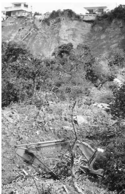
地すべりの危険地帯で活動する「ロボQ」操作の大型機械（沖縄・中城）
