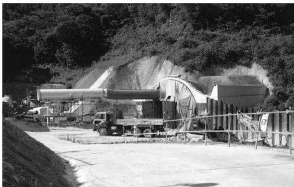
坑内の空気を浄化するため大きな換気パイプが装置されている
