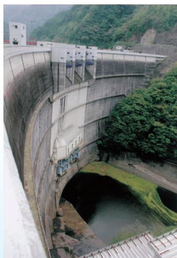
完成した下笠ダム
