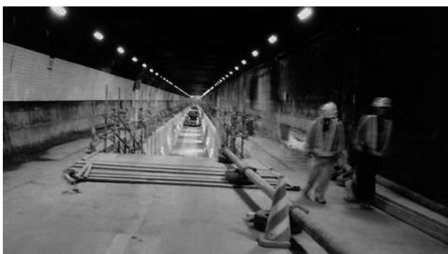
完成から50年を超えて、利用する自動車は1日3万台を大きく超え、床版などの痛みは激しく、点検補修が常に行われている。
