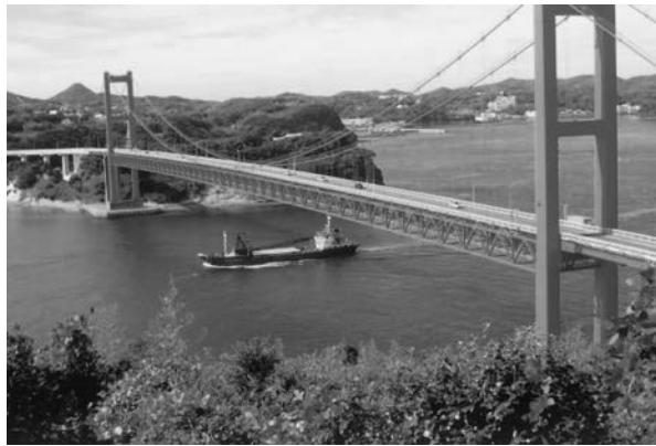
平戸大橋・1977年完成、橋長・879m、最大支長・465m、吊り橋、平戸市
