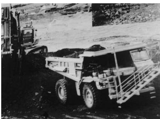
雲仙での無人施工。遠隔操作で、安全に工事が進む。
