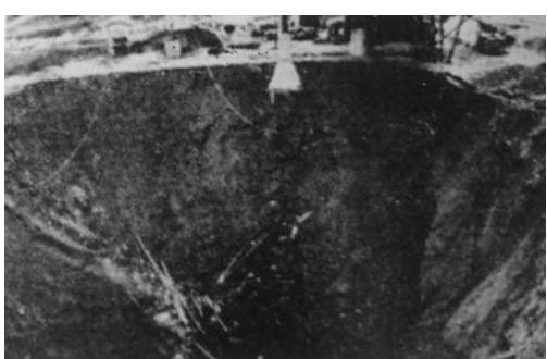
コンクリートの側面が崩れ、立て坑崩壊、痛恨の犠牲者を出した。
