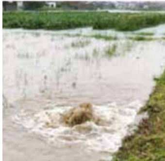
久留米市北の町金島堤防裏の水田より自噴7月7日10時50分
