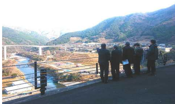
現地調査状況
