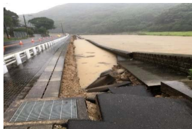
①松浦川支川徳須恵川の護岸とR202歩道の崩壊状況
